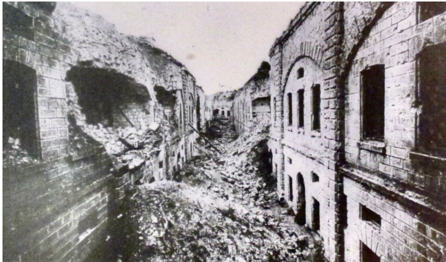
Le fort a subi d'importantes destructions
